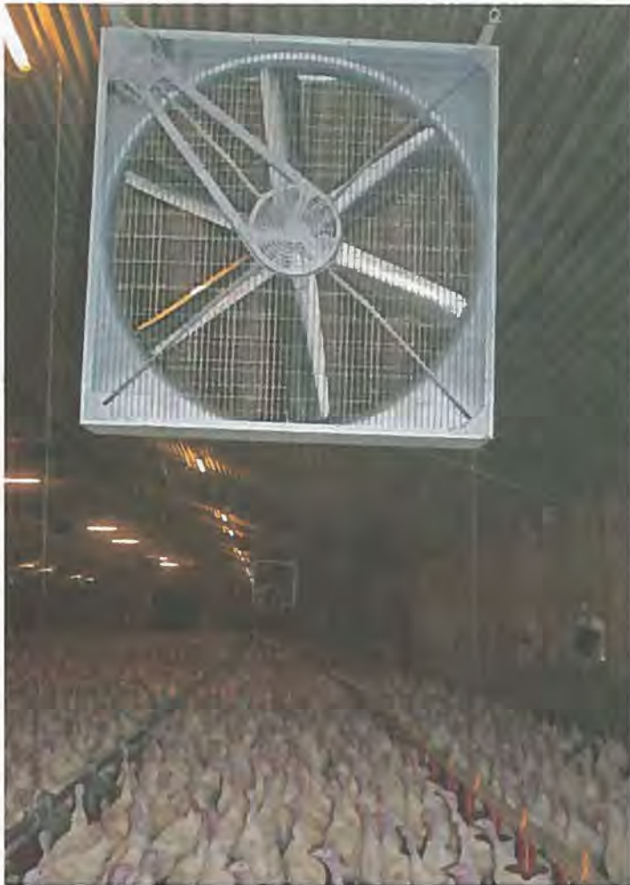
Im 25 m breiten Stall sind die neun Zusatzlüfter in drei Reihen angeordnet, so dass der gesamte Tierbereich mit Frischluft versorgt wird.
