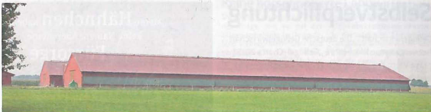
Die beiden Hahnenställe wurden 2011 gebaut, hier hat Jörg Wempen sofort Sprühkühlungen mit installieren lassen.
