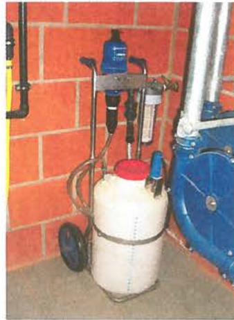
Durch den Einbau eines Medikators können gezielt flüssige Zusatzstoffe ins Wasser eindosiert werden.
