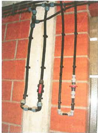
Bei der Installation der Wasserleitungen muss unbedingt darauf geachtet werden, dass sie nicht durchhängen.
