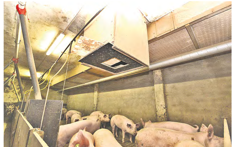
Auch mit von Hand bedienten Schieberkonstruktionen lässt sich die warme Luft bei Bedarf länger im Stall halten.
