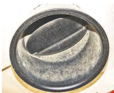
Der Öffnungswinkel der Abluftklappe bestimmt den Luftdurchsatz.
